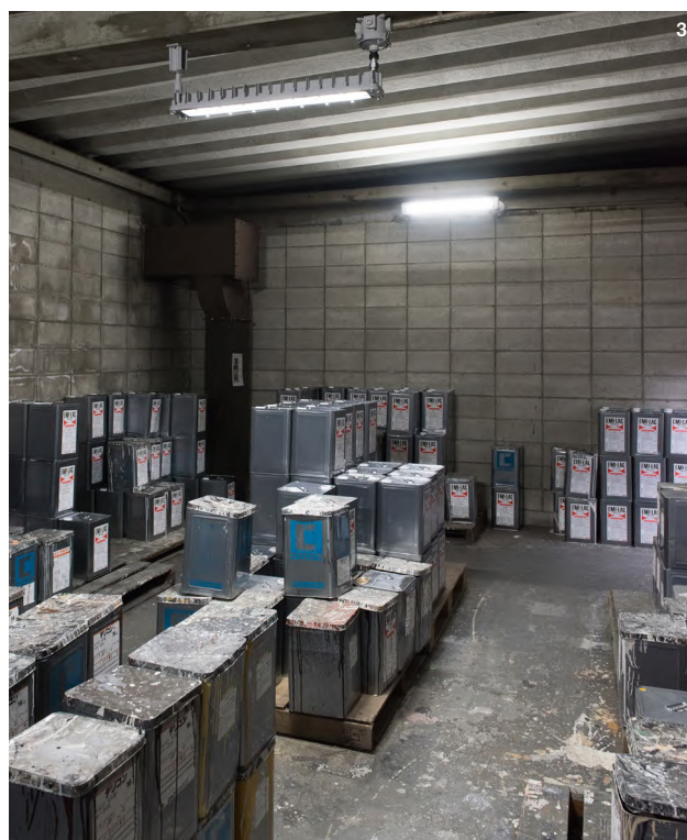
1 人感センサー付きの高天井照明の倉庫棟。2 工場奥の閉塞的な空間も明るく。3 塗料倉庫は防爆仕様です。
