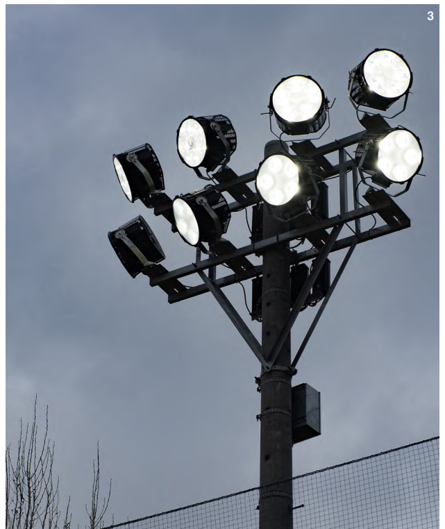
1 明るく生まれ変わったグラウンド。2 投手にも捕手にも配慮した配光。 3 新規設置のポールと投光器。
