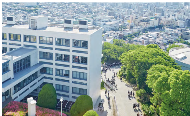
1 眩しすぎず明るくなった体育館。2 無線式コントローラーで調光。3 校舎外観。
